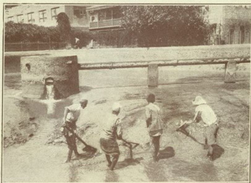
منظر تنظيف قاع المرشحات Curetage des bassins de filtration
