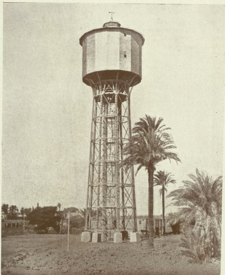
منظر خزان أجهزة توريد مياه مدينة الفيوم
