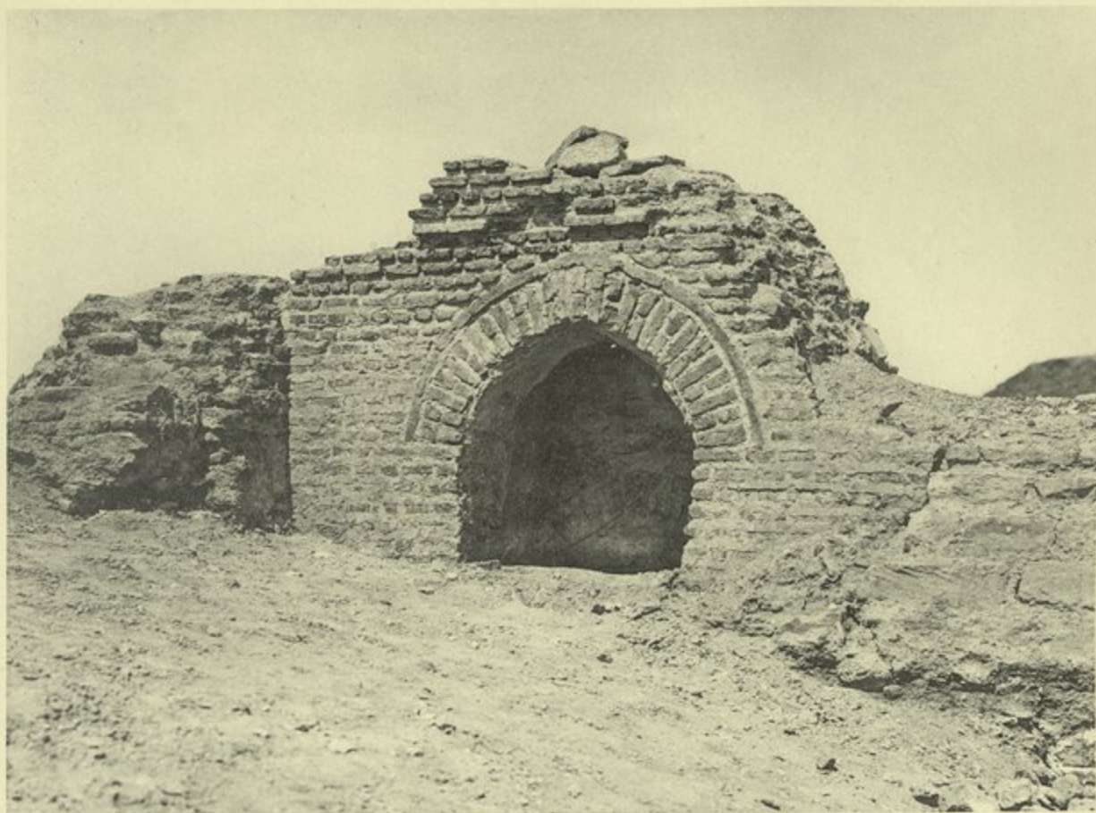
Ouverture d'un égout. — فتحة مجرور
