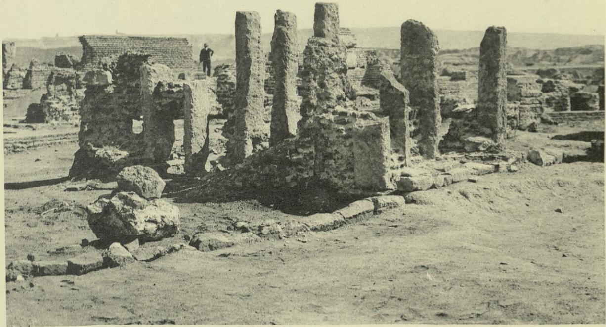
Détails de construction. — تفاصيل من الأبنية
