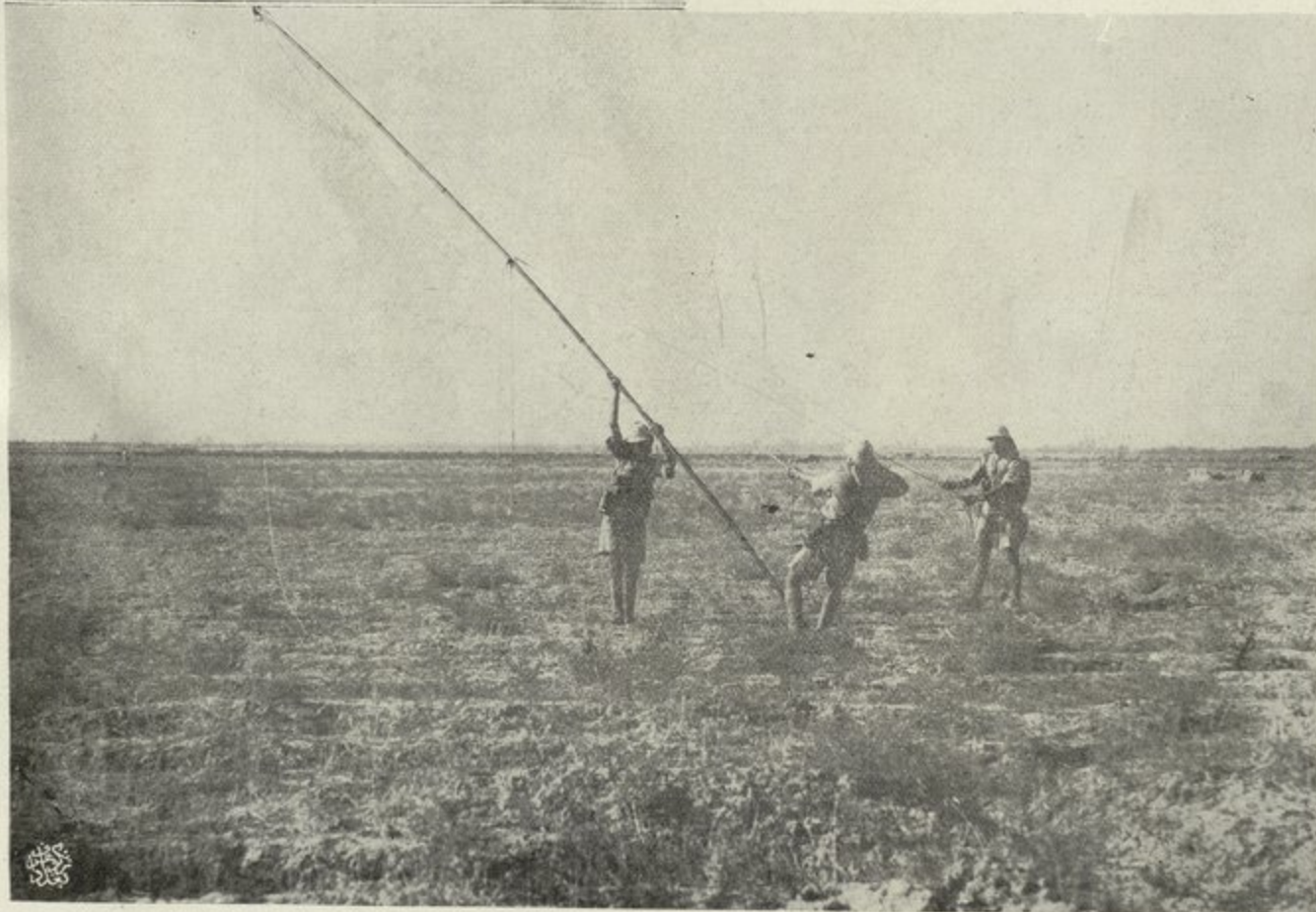
Signallers erect a W/T Station. جنود المخابرة ينصبون محطة لاسلكية
