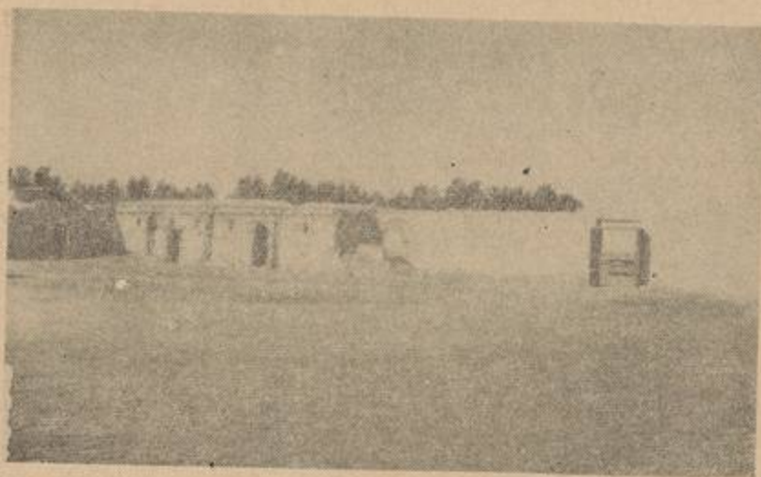
منظر داخلي للقصر الاحمر قبل ترميمه
