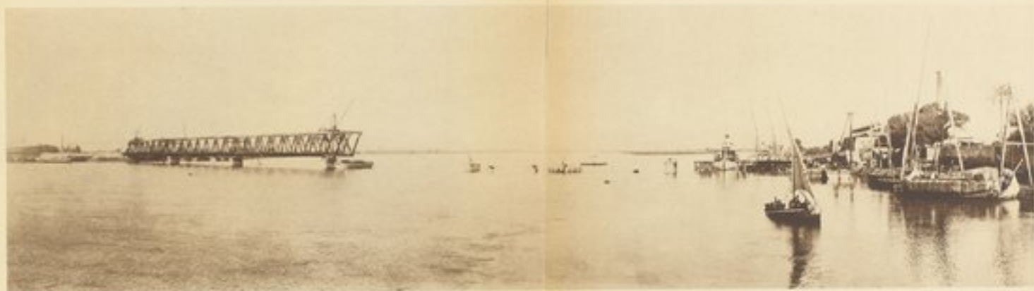
منظر عام لكوبرى مسوق الحديد اثناء اقامة حديد الكوبرى الجديد
