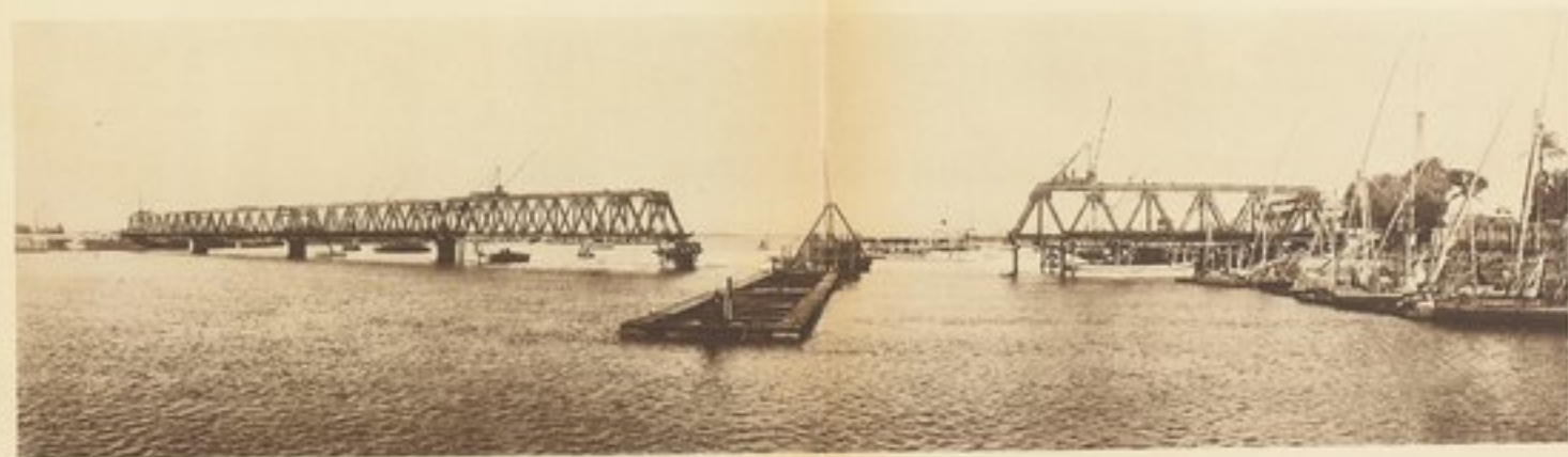
منظر عام اثناء اقامة حديد كوبرى مسوق الحديد بعد ازالة حديد الكوبرى القديم
