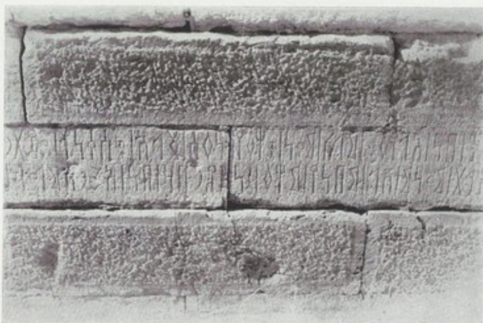
شكل ٣٧ — الصورة الثانية للنقش الثاني .
