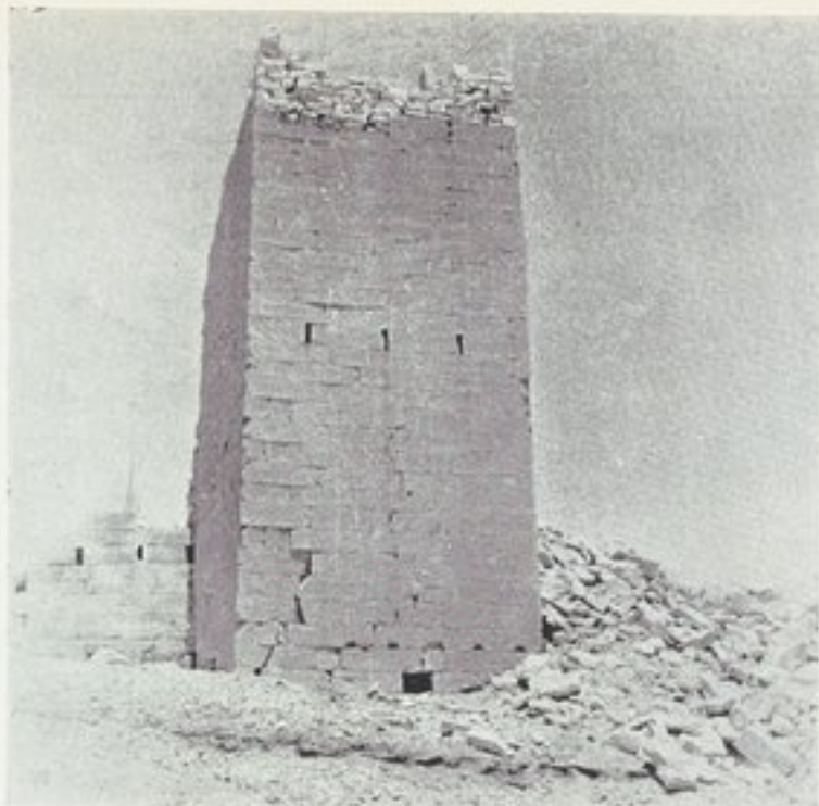
شكل ١٨ — البرج الجنوبي للباب الشرق لمعين من خارج الخربة . وتوى به المزامل والفتحة التي أسفل حدار واجهته الشرقية وكذلك الثانية أسفل الجدار الجانبي الجنوبي للبرج ، وفي هذا الجدار يوجد النقش الحادي عشر . ويرى في جنوب البرج جزء من سور المدينة وبه مزامل وهو الذي به النقش الثاني عشر .
