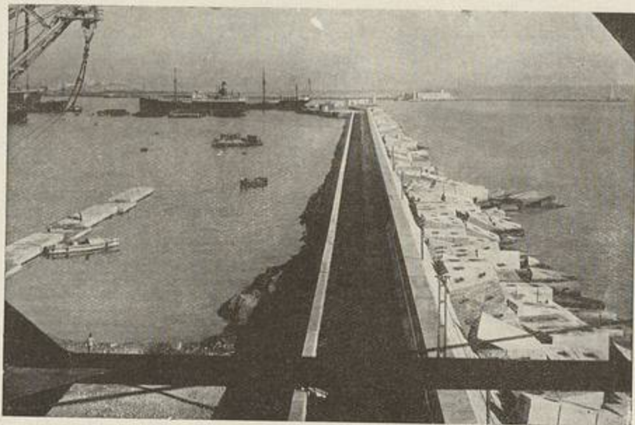
Construction du môle à charbon
