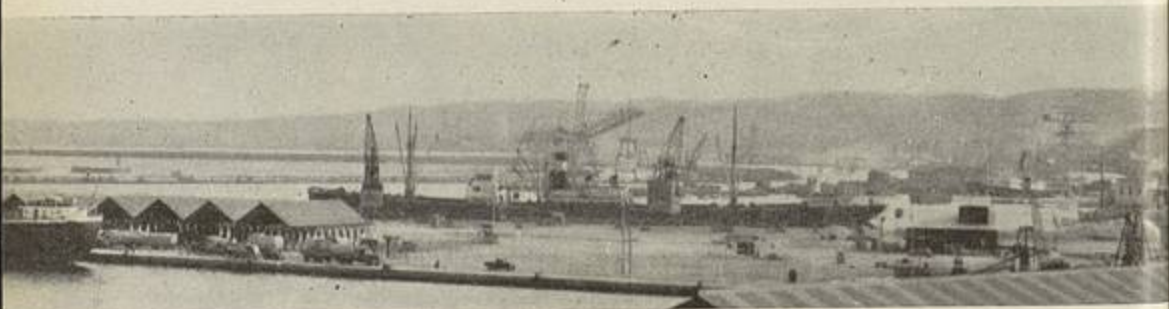
Vue d'ensemble du môle de France où s'édifie la « nouvelle gare maritime »
