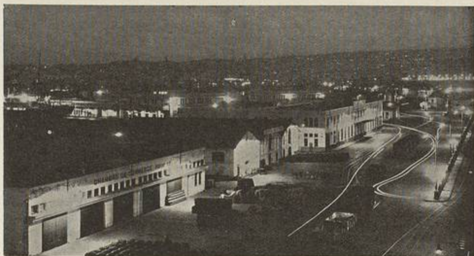
Hangars n° 1 et n° 2 de la Chambre de Commerce - Quai nord (Vue de nuit)
