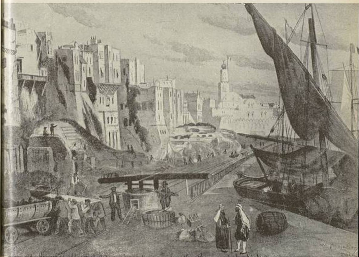
Les fondations du boulevard de l'Impératrice
