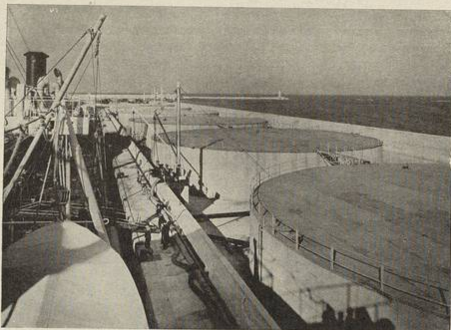
Les réservoirs de la compagnie Venture-Weir
