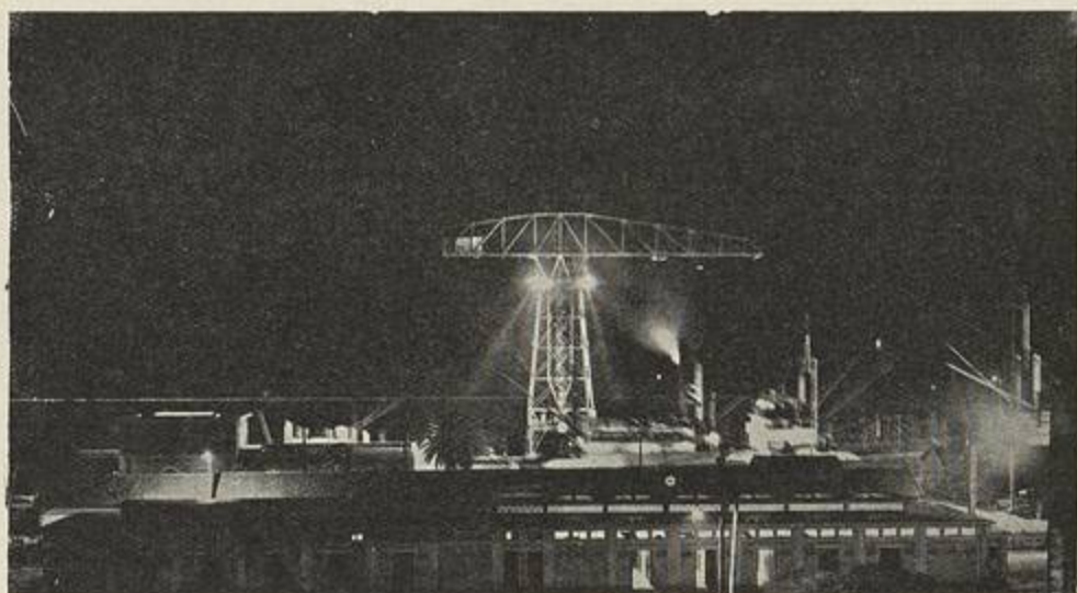
Travaux de nuit aux bassins de radoub
