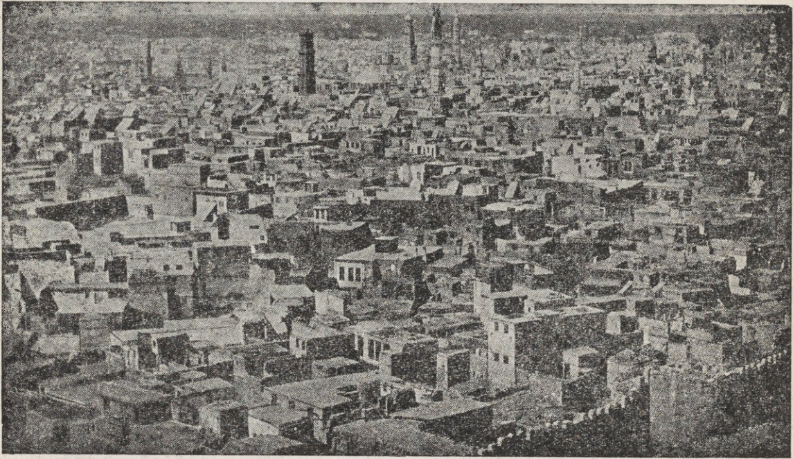
القاهرة — منظر لبعض أحياء القاهرة المزدهمة بالسكان بقسم الجمالية والدرب الأحمر وترى بالصورة بقايا من السور المحصن بالأبراج الذى بناه صلاح الدين الأيوبي
