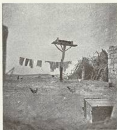
(ب) برج حمام مركب من سارية خشب موضوعة وضعا رأسيا ومركب عليها لوحة أفقية مرصوص فوقها صفايح فارغة يعشش فيها الحمام بشبه جزيرة سيناء
