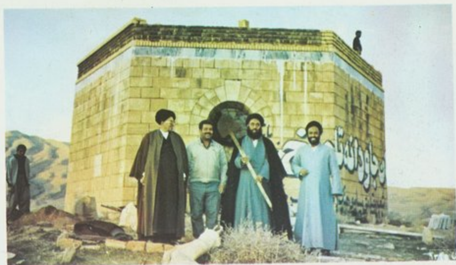
المرقد المطهر للسيد الجزائري (رح) اثناء البناء الحديث سنة (١٤٠٢)
